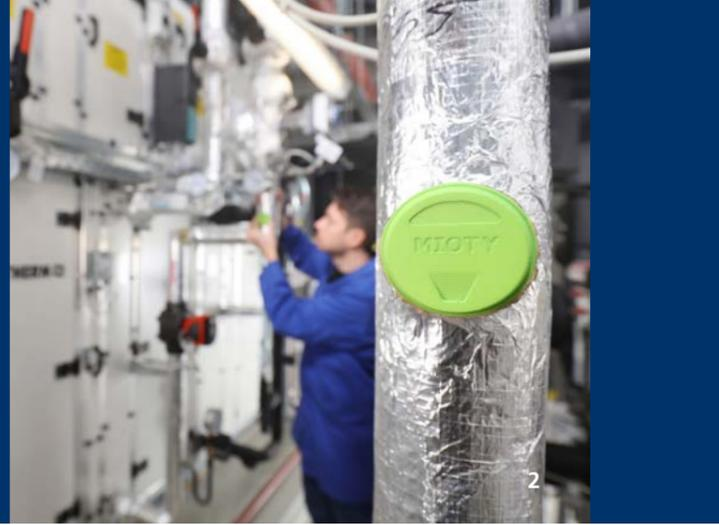
2 Mit der drahtlosen MIOTY-Technologie können Sensordaten über bis zu 15 Kilometer übertragen werden.
